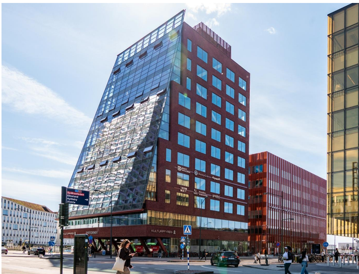
Figur 5: Bild på Fyrtornet efter slutbesiktning. Här har fältmätningar utförts under produktion. Ett permanent system har installerats i samband med slutbesiktning för framtida studier. Foto: Granitor
